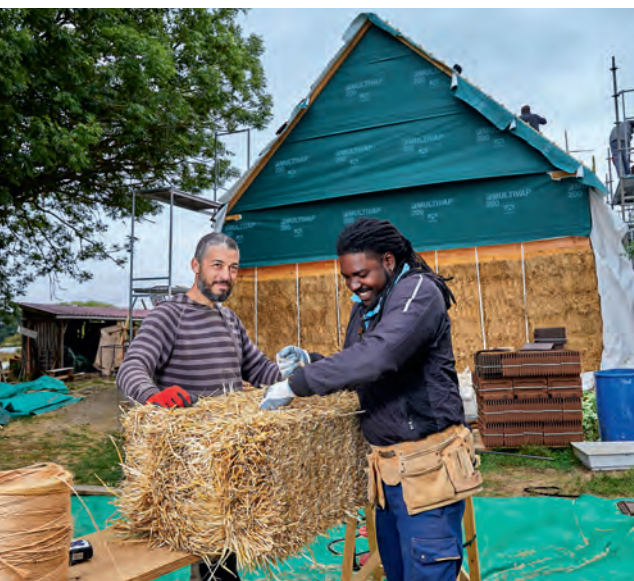
En haut, l'atelier d'insertion Mode Estime à l'Île Saint-Denis. A gauche, un café contact pour l'emploi, ici à Gagny. A droite, des salariés en insertion chez Apij Bat, sur un chantier en Seine-et-Marne.
