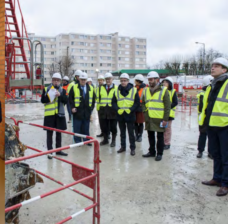
4 mars 2017 • Montreuil. Stéphane Troussel, président du Conseil départemental, Gérard Cosme, président d'Est Ensemble, ont participé avec le maire Patrick Bessac et le député Razzy Hammadi, à une visite de chantier du bassin de rétention de la Fontaine des Hanots. Cet équipement servira à lutter contre les inondations lors des fortes pluies et à préserver la qualité de l'eau de la Marne et de la Seine.
